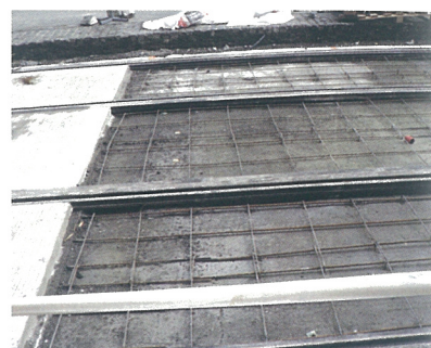
5. ábra. Bekötővassal kiépített pályalemez a betonozás előtt
