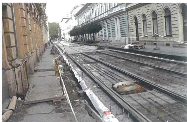
6. ábra. Bekötővassal kiépített rezgécscillapított pályalemez betonozás előtt
