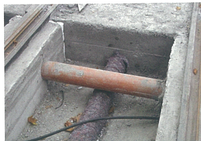
8. ábra. Az 1-es sz. villamosvonal fűvesített gerendás felépítmény előre gyártott műanyag köpenyes távtartóval
